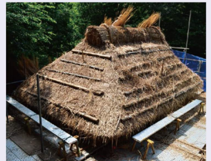
2014年度 蚕影山祠堂の屋根葺き替えの様子
