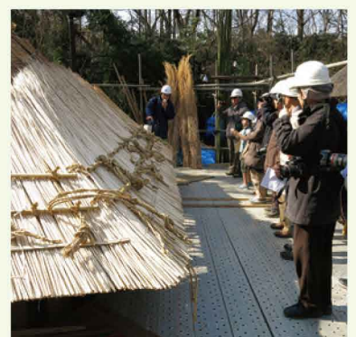
水車小屋屋根葺き替え見学 写真は2015年2～3月の旧工藤家外便所の屋根葺き替えの様子。
