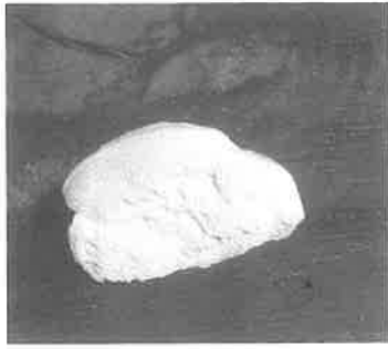
雨漏りにより内部にキノコ発生（旧山田家住宅）
