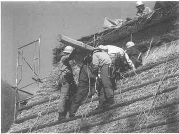
加工を終えた新しい水梁を取付けているところ
