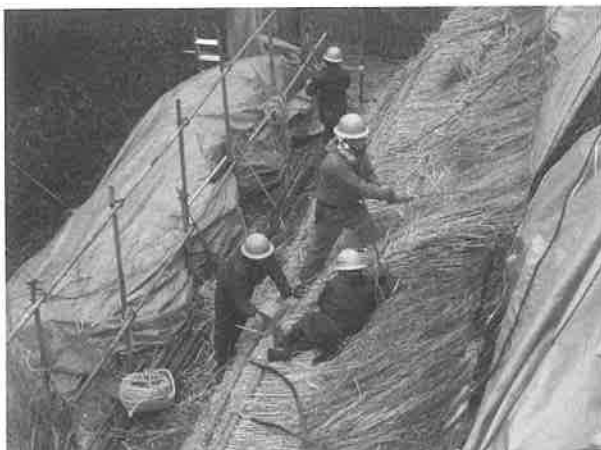
屋根葺き替え作業中 茅の上の横棧がまんさくの幹
