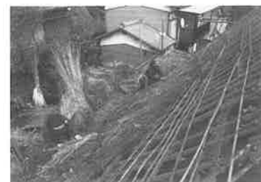
土蔵茅葺き作業中
