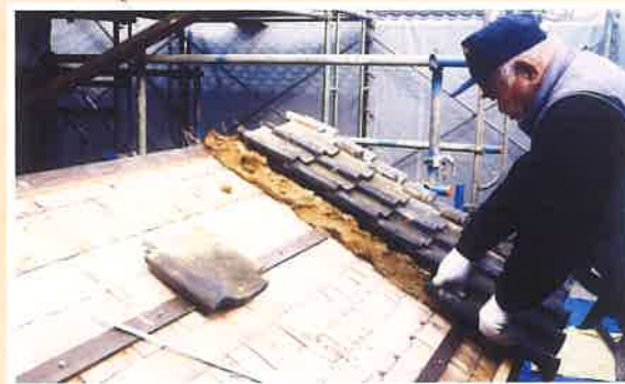
門の瓦屋根葺き替えの様子(平成15年)
