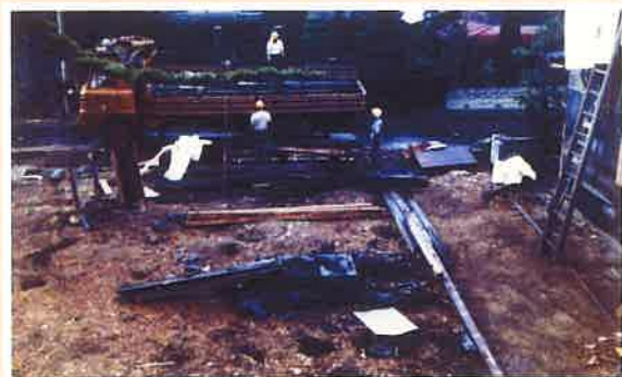
解体終了後の敷地(昭和44年)
