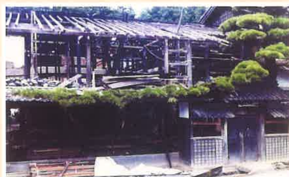
解体の様子(昭和44年)
