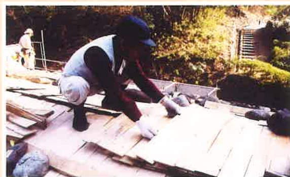
屋根修理の様子(平成15年)
