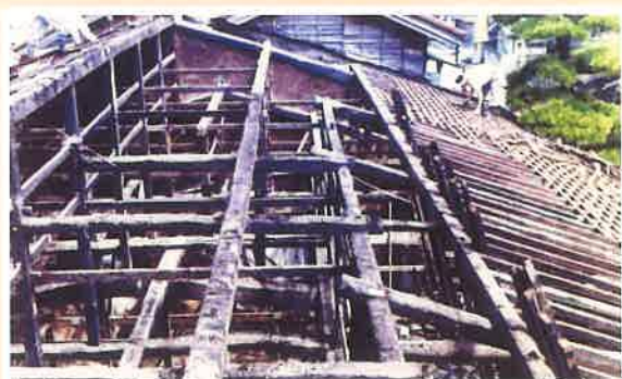
解体の様子(昭和44年)
