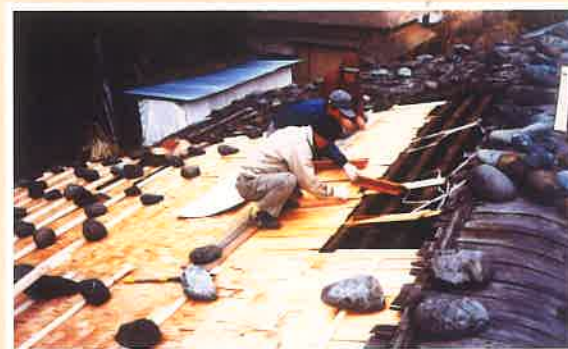
屋根修理の様子(昭和61年)
