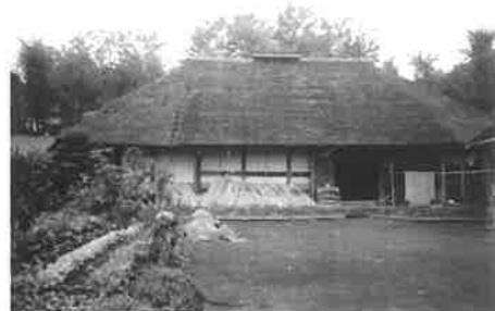
移築直前の旧北村家住宅
