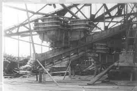
浅草寺本堂 施工中写真 昭和27年10月撮影
