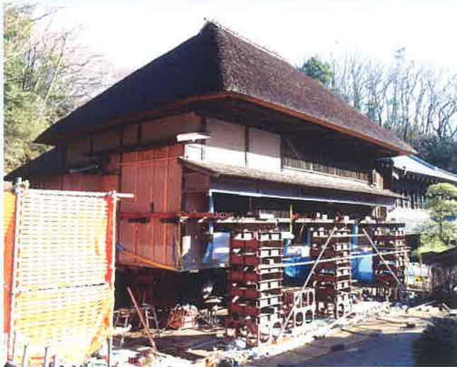
旧鈴木家住宅耐震工事の様子
