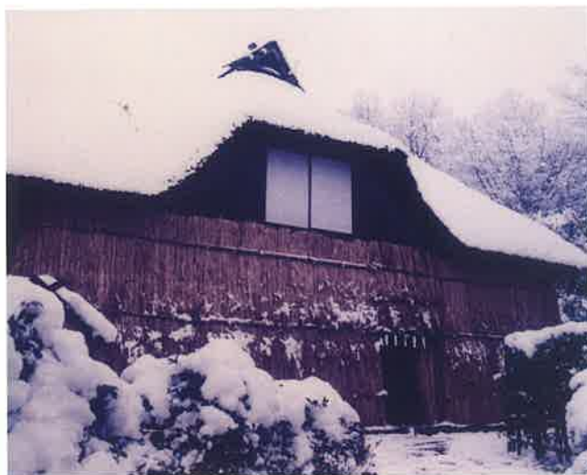
旧菅原家住宅雪囲いの様子 [平成6(1994)年]
