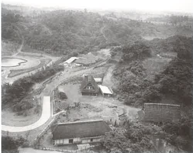
信越の村(手前)と復原工事中の旧作田家住宅(奥) (東京新聞提供)
