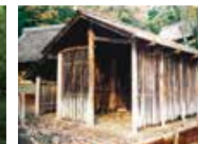
栋持柱の木小屋
