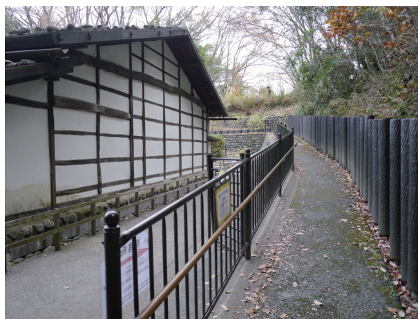
増設した車椅子用スロープ
