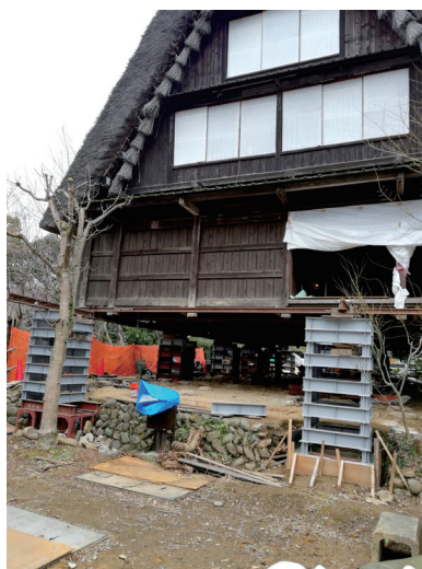
耐震補強工事
