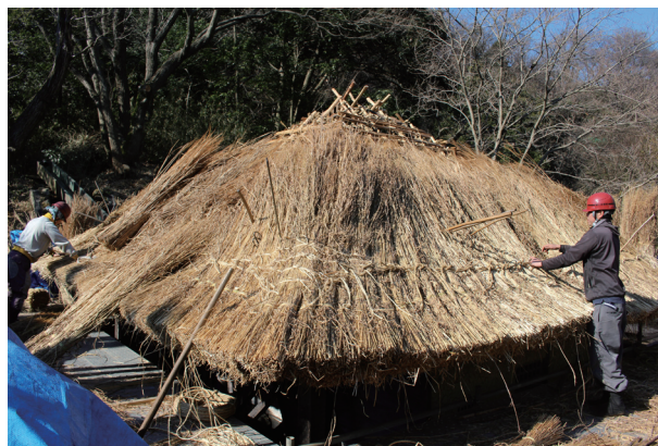
茅葺屋根の葺替え
