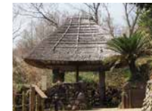
12. Speicher auf Pfählen
