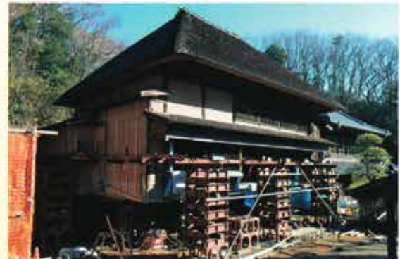
旧鈴木家の耐震補強工事
